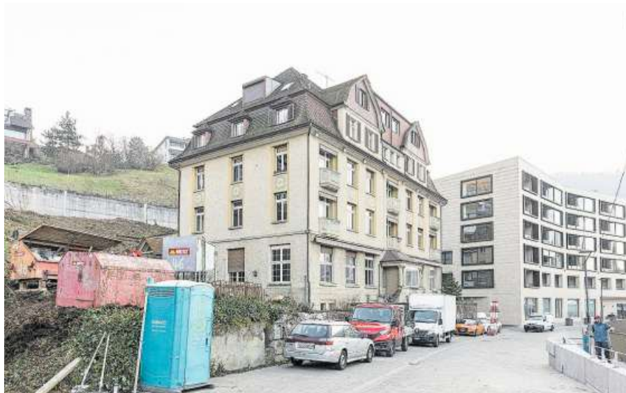
Anfang Februar startet der Abriss des «National»-Gebäudes.
